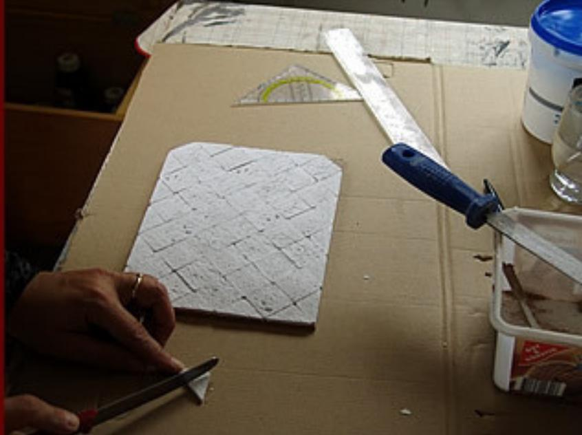
Die Fliesen werden auf die Bodenplatten (17 x 23 cm) geklebt, in diesem Fall diagonal. Um Fliesen zuzuschneiden, kurz mit dem Messer anritzen und dann einfach durchbrechen.
