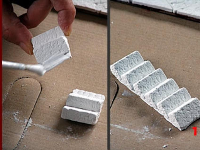
Während die Fliesen trocknen, kann man die Zeit nutzen um einige Vorarbeiten zu leisten. Die drei Treppenelemente werden zusammengeklebt. Anschließend wird die kleine Verbindungszunge, die sich an der obersten Stufe befindet, einfach abgebrochen (1).
