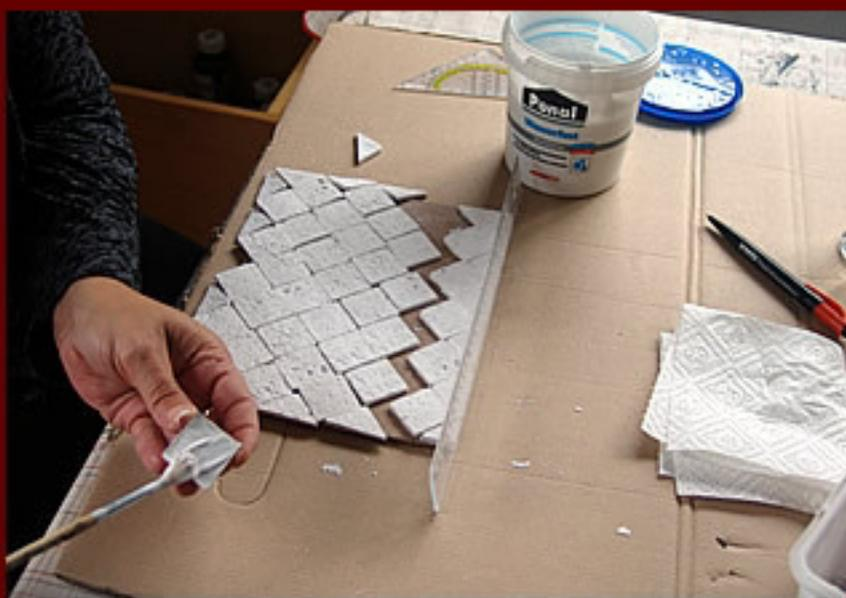
Nun klebt man die Fliesen auf. Hier lohnt es sich sorgfältig zu arbeiten, damit die Fugen eine gerade Linie bilden. Nachdem die erste Reihe geklebt ist, legt man ein Lineal an, um einen geraden Rand zu bekommen. Die Fliesen lassen sich in den ersten 5 min. noch verschieben, so dass man noch kleinere Korrekturen vornehmen kann.
